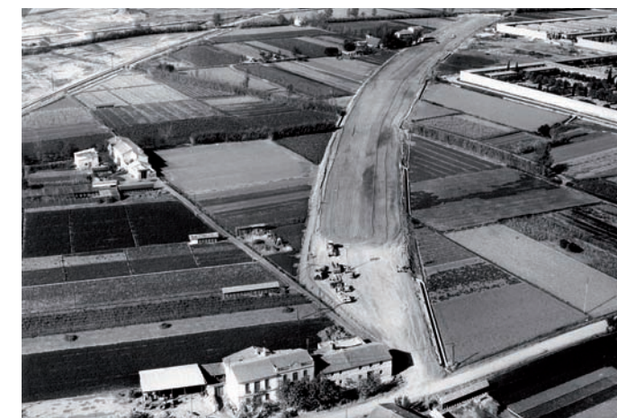
En primer término, futura plataforma del ferrocarril. Al fondo, trazado del nuevo cauce
