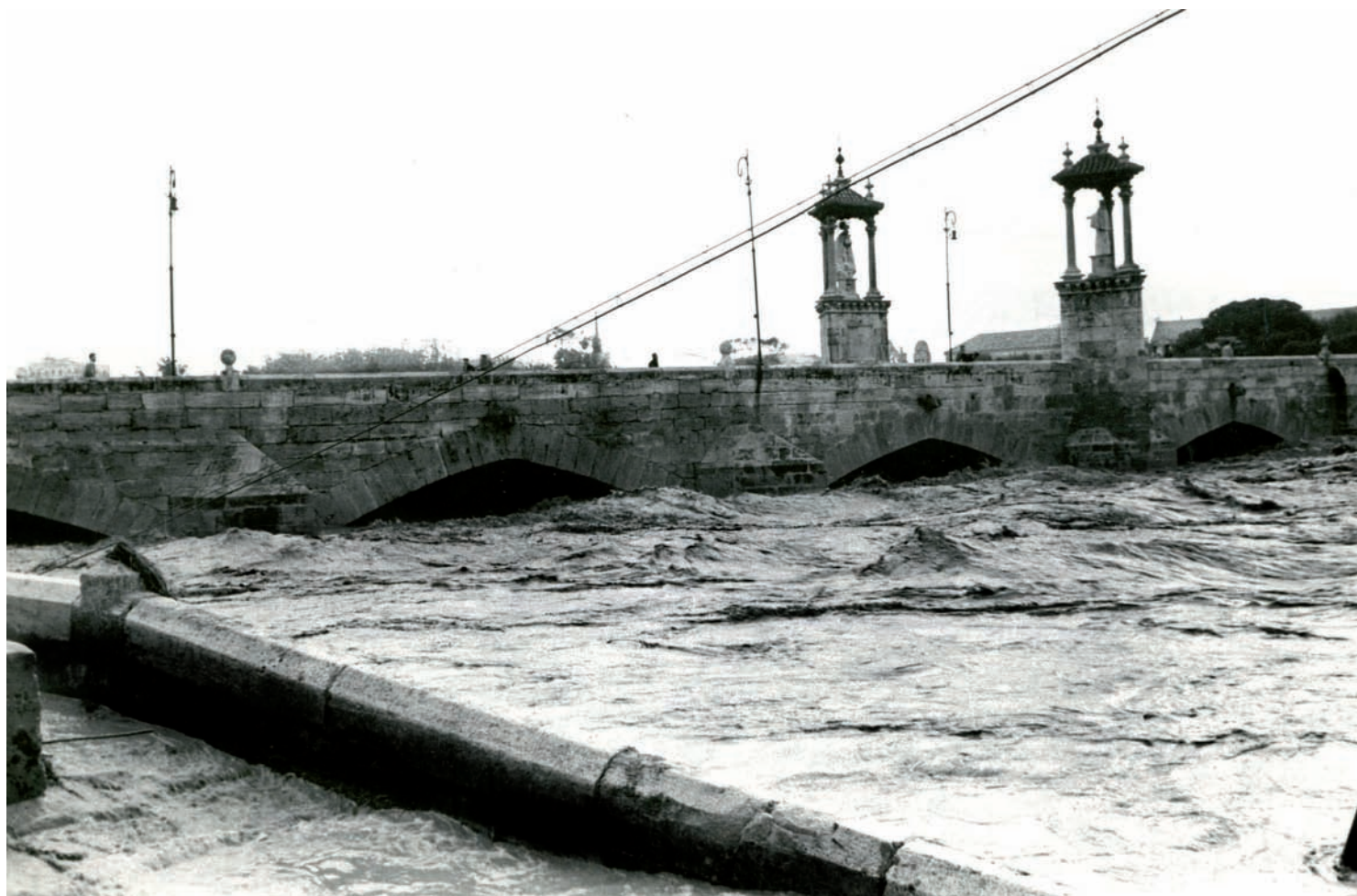
Puente del Mar en la ciudad de Valencia. 1957 Las turbulentas aguas del Turia prácticamente cubren los arcos del puente
