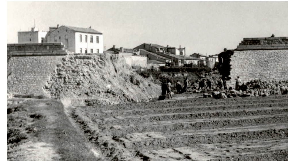
Reparación del dique y pretil de cierre del meandro cortado. 1947
