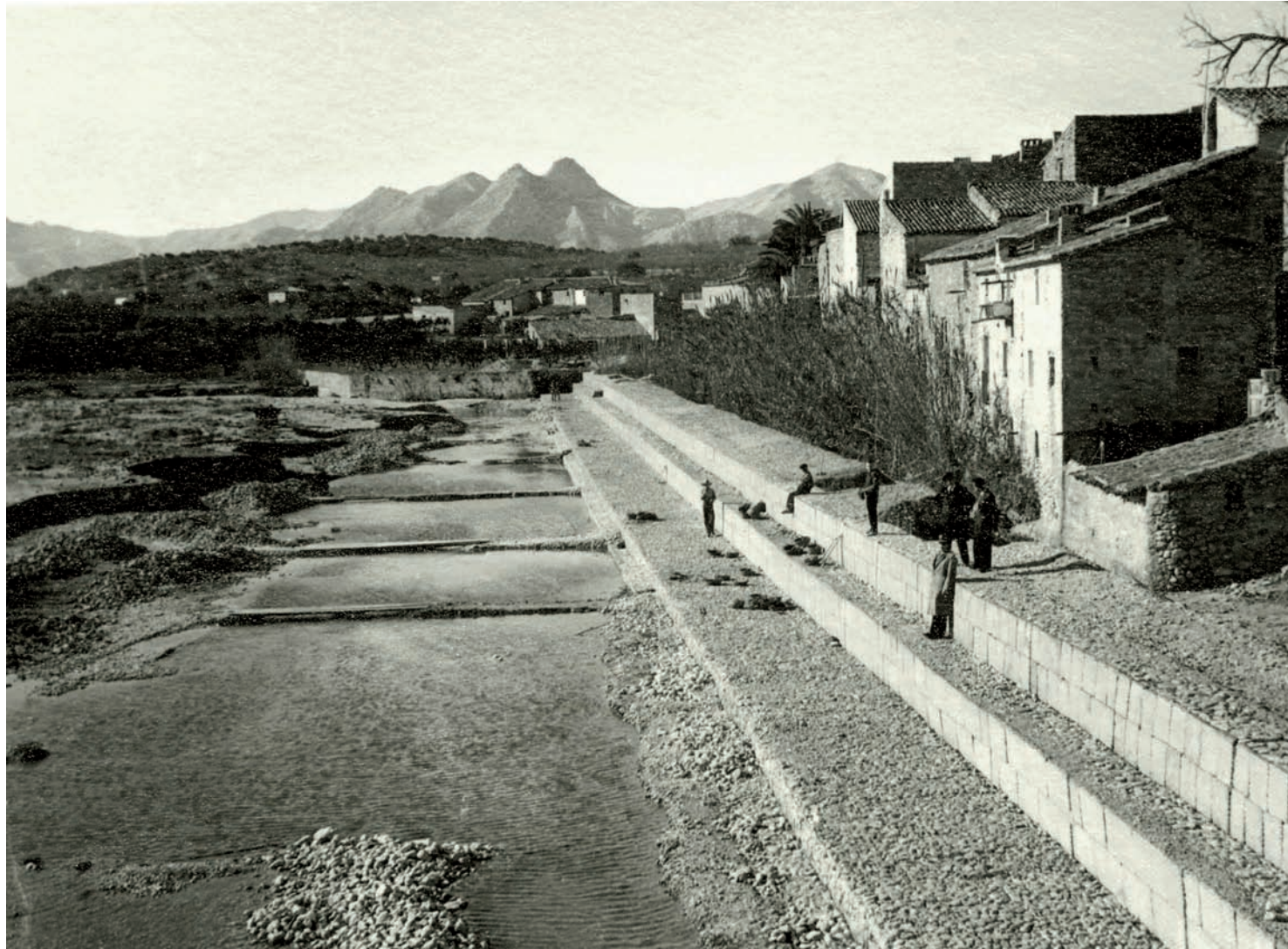
Defensa de Beniarbeig (Alicante). 1940 Alineación de la margen mediante gaviones. Al fondo la Serra de Segaria
