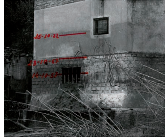
Molino de Argelita (Castellón). 1967 Niveles de crecidas (1922, 1957 y 1967)
