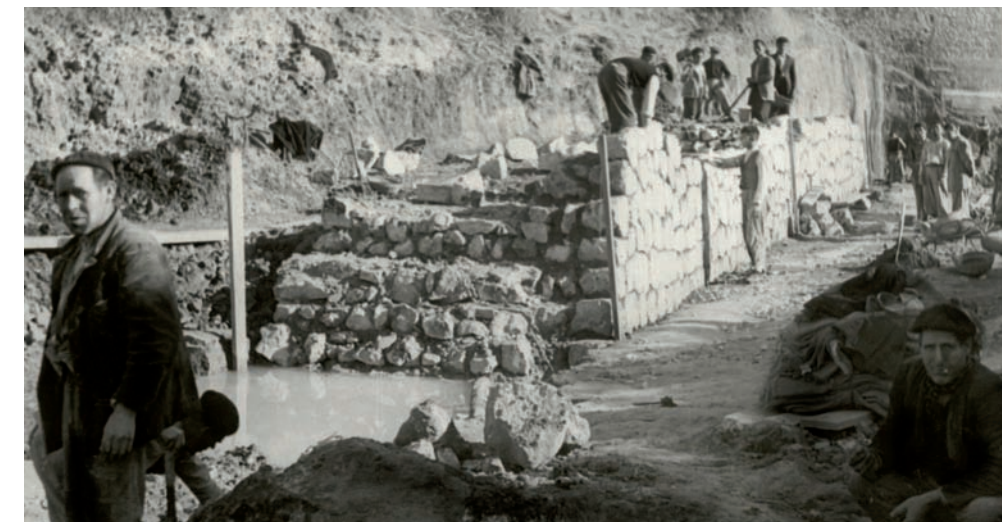
Desvío del Barranc de Barxeta y fijación de margen mediante mampostería.1960
