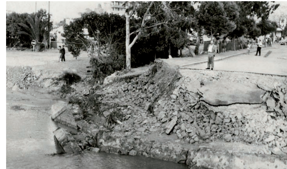
Sant Joan (Alicante). Septiembre de 1963 Daños en infraestructuras por crecida torrencial
