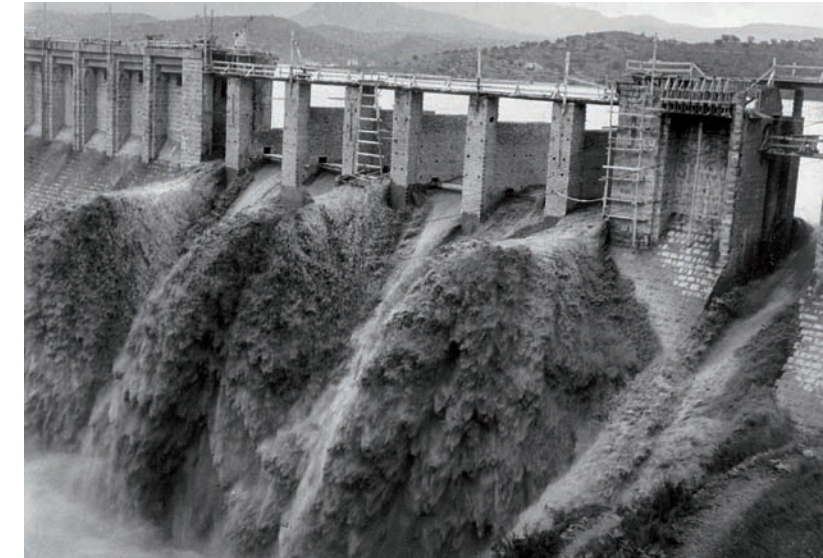
Embalse de Sitjar, Onda (Castellón). 1957 Presa en fase de construcción. La avenida del río Mijares (Millars) desborda el aliviadero
