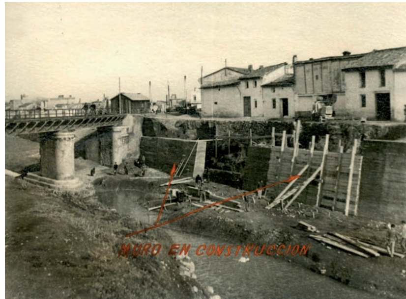
Construcción del muro de contención, junto al puente del ferrocarril. 1940
