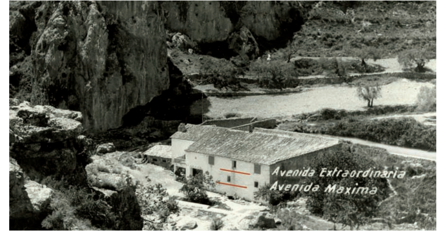
Molino hidráulico, l'Alcora (Castellón). 1948 Acotación de niveles de avenida.
