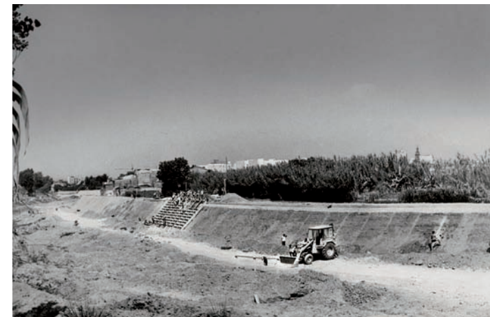
Continuación de la defensa, en la margen izquierda del Magro.1971
