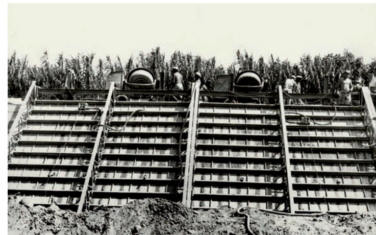
Detalle de los trabajos.1971
