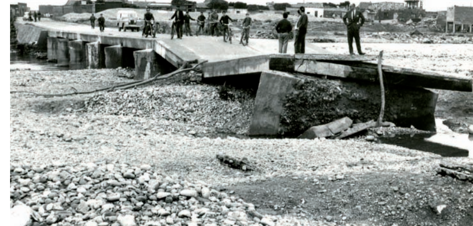
Puente entre el Puerto de Sagunto y Canet (Valencia). Octubre de 1965 Estado de la obratras la avenida del Palancia, muy cerca de la desembocadura
