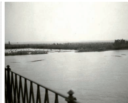
Puente de hierro de Fortaleny (Valencia). 1949 Inspección del río Júcar (Xúquer) (días 17, 19 y 24 de Febrero)
