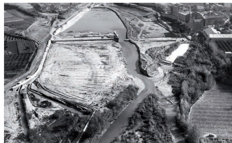
Derivación del río Turia inmediata al Assut del Repartiment
